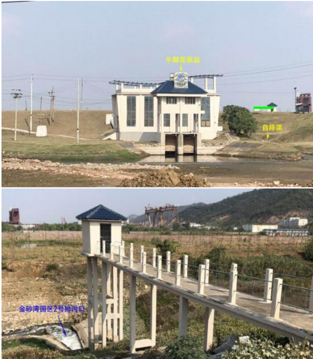
图 3.4-1 赛得利（九江）纤维有限公司入河排污口入河方式图
