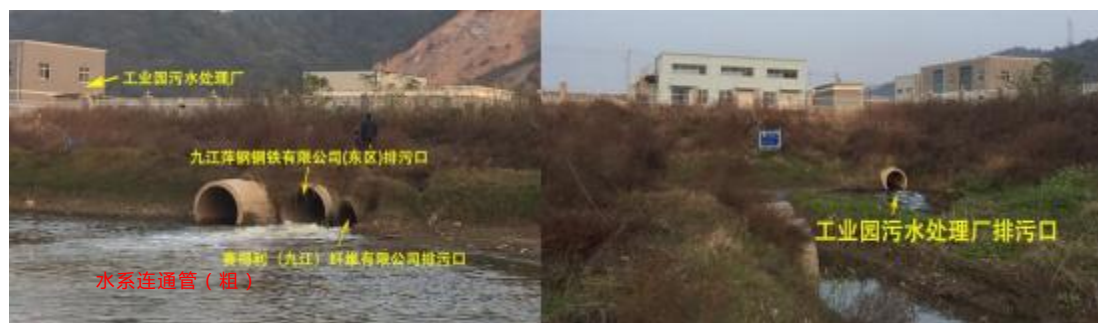
图 3.4.1-2 金沙湾工业园 2 号综合排污口 3 股废废水汇入口现场图
