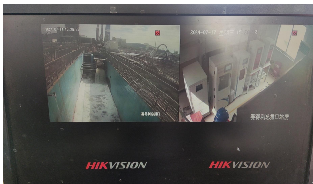
厂区内视频监控
